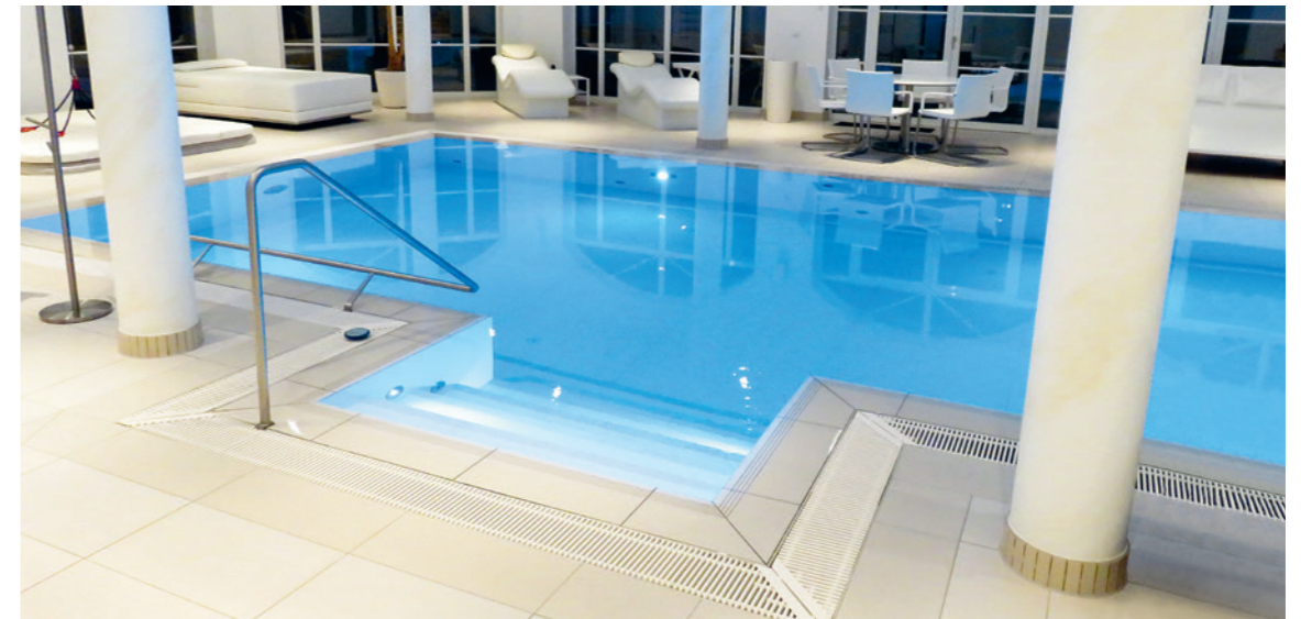
Betonbecken gefliest mit Überlaufrinne
